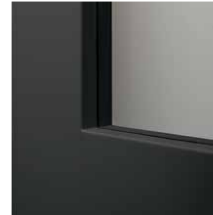
DETAIL RECHTE PROFILERING MET INVISIBLE BEGLAZING
