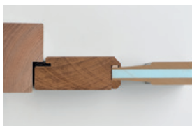
Doorsnede geïsoleerde deur 54 mm.
